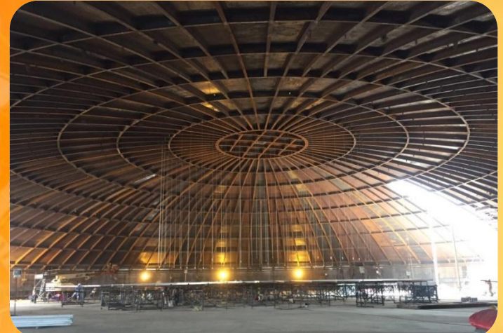
Roof Installation at LNG Tanks, Ennore
